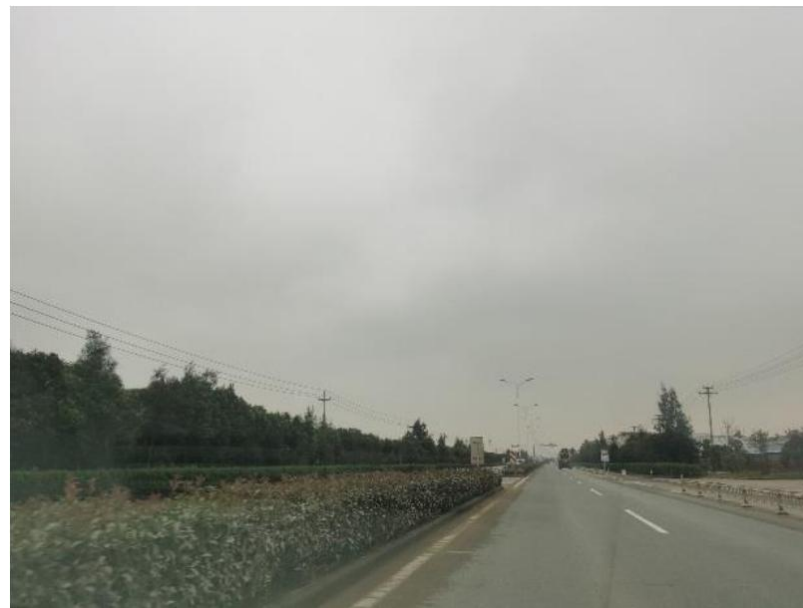
厂区北侧徐福大道
