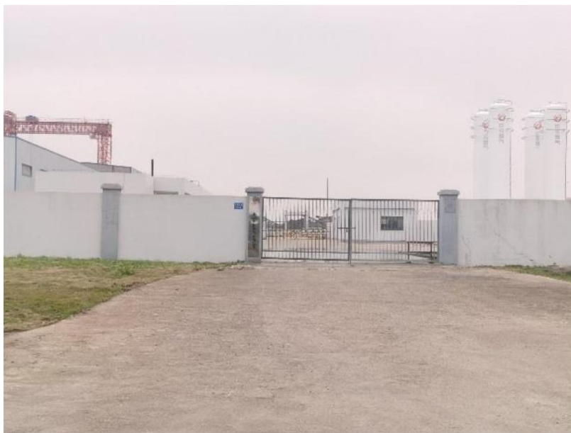
厂区西侧浙江中裕燃气有限公司
