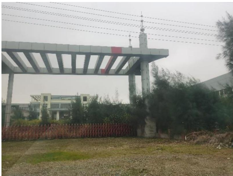
厂区东侧废弃厂房
